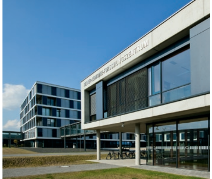
Im Q-Cells-eigenen Forschungszentrum wird vor allem an der Effizienzsteigerung der Solartechnologie gearbeitet. | Work carried out in Q-Cells' own research centre primarily focuses on increasing the efficiency of solar technology.
