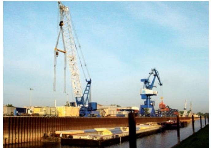
Der Elbehafen Aken erfüllt als trimodale Schnittstelle des mitteldeutschen Güterverkehrs eine wichtige Aufgabe beim Umschlag von verschiedensten Ladungen. Elbehafen Aken port plays an important role in handling various goods as a trimodal interface in Central German freight transport.
