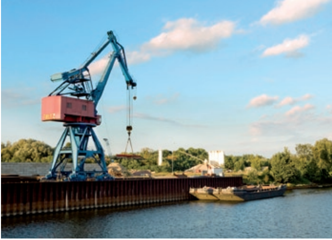
Ein Drehkran bei Verladearbeiten an der Kaianlage des Roßlauer Elbehafens. A slewing crane loading on the quay of Roßlau's Elbe port.
