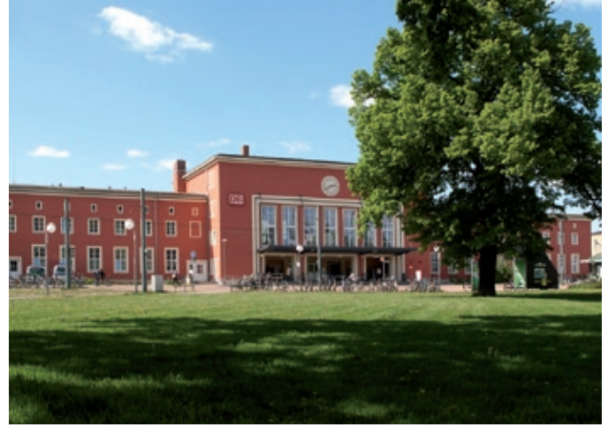
Der überregional bedeutsame, 2010/11 umfassend sanierte Dessauer Hauptbahnhof bietet Direktverbindungen nach Berlin, Leipzig, Magdeburg, Wittenberg und Köthen. The nationally renowned Dessau central station was renovated in 2010/2011 and offers direct connections to Berlin, Leipzig, Magdeburg, Wittenberg and Köthen.
